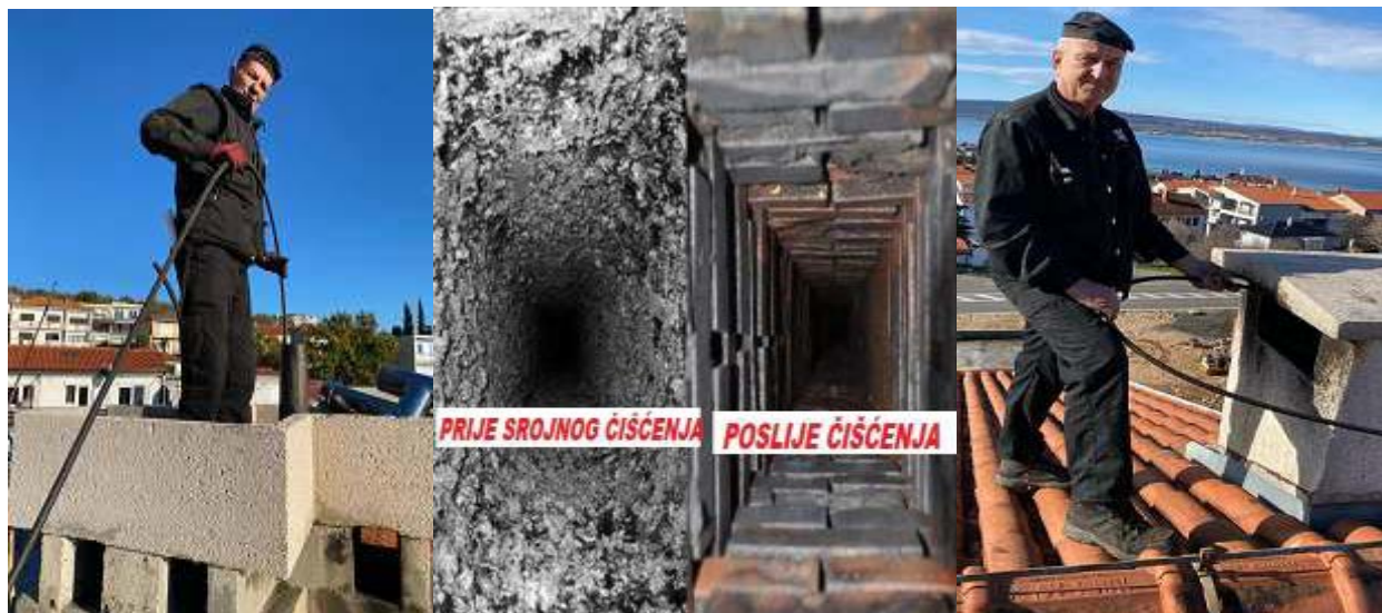
Provjera ventilacijskog kanala iz prostora
